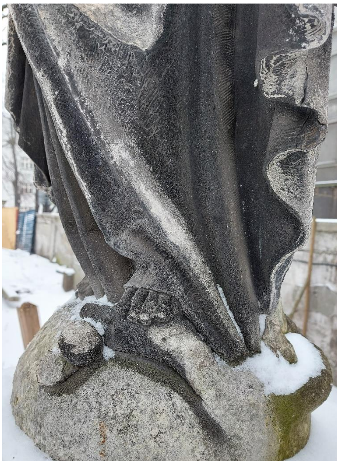
Fot.2. Figura Matki Boskiej Niepokalanej, Pl. Kossaka 4, Kraków. Widoczny bardzo zły stan rzeźby, na większej części powierzchni czarna patyna. Na częściach wypukłych, obmywanych wodą deszczową patyna wypłukana wraz z warstwą kamienia. W prawej dolnej części widoczny w miejscach zacienionych widoczny nalot z mchów. Fot. D. Narowska Avonza, luty 2021.
