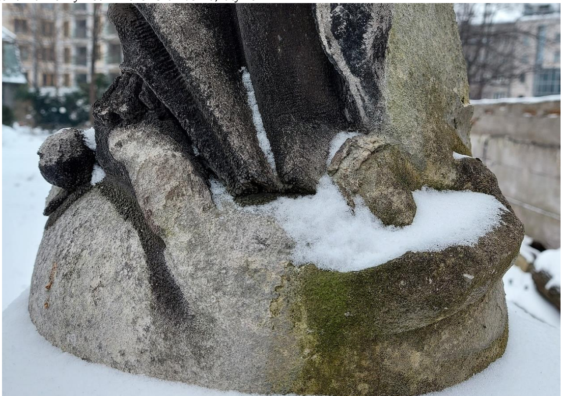
Fot.4. Figura Matki Boskiej Niepokalanej, Pl. Kossaka 4, Kraków. Widoczny bardzo zły stan detalu rzeźbiarskiego. Na częściach wypukłych, obmywanych wodą deszczową patyna wypłukana wraz z warstwą kamienia. W prawej dolnej części widoczny w miejscach zacienionych widoczny nalot z mchów. Ubytki formy związane z korozją kamienia i odrywaniem się patyny w dużym stopniu unieczystniające formę węża u stóp Marii. Fot. D. Narowska Avonza, luty 2021.
