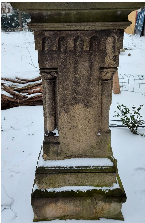
Fot.8 Figura Matki Boskiej Niepokalanej, Pl. Kossaka 4, Kraków, postument. Widoczny bardzo zły stan. Fragmenty mniej narażone na bezpośrednie działanie wody opadowej pokryte są warstwą patyny i mchów. Na centralnej części rozległa destrukcja spowodowana odpadaniem patyny, charakterystyczne rozwarstwianie się piaskowca. Ubytki formy największe przy kolumnie z prawej strony. Fot. D. Narowska Avonza, luty 2021
