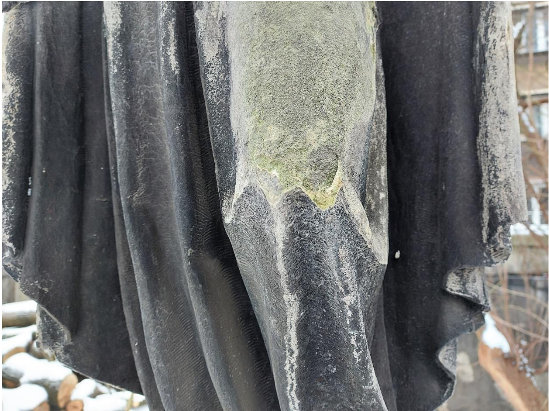
Fot.5. Figura Matki Boskiej Niepokalanej, Pl. Kossaka 4, Kraków . Na zdjęciu fragment szaty na kolanie postaci z rozległym ubytkiem spowodowanym odpadaniem warstwy patyny oraz dezintegracją zubożonego w lepiszcze kamienia. Na pozostałej powierzchni czarna warstwa patyny fałszywej. Fot. D. Narowska Avonza, luty 2021.
