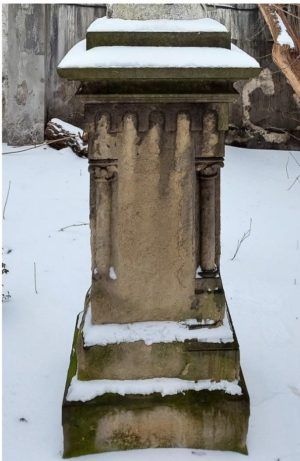
Fot.7 Figura Matki Boskiej Niepokalanej, Pl. Kossaka 4, Kraków, postument. Widoczny bardzo zły stan. Fragmenty mniej narażone na bezpośrednie działanie wody opadowej pokryte są warstwą patyny i mchów. Na centralnej części rozległa destrukcja spowodowana odpadaniem patyny, charakterystyczne rozwarstwianie się piaskowca. Ubytki formy największe przy kolumnie z lewej strony oraz na narożnikach stopni. Fot. D. Narowska Avonza, luty 2021
